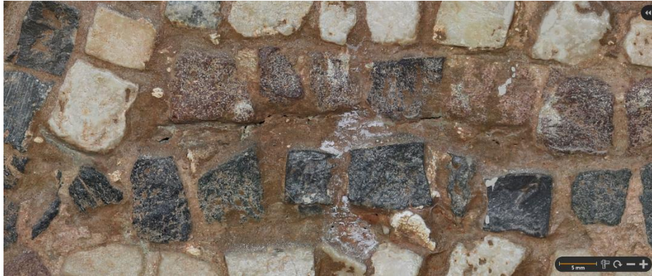
Fig. 21. Presencia de grietas y oquedades en los morteros de reintegración con teselas
