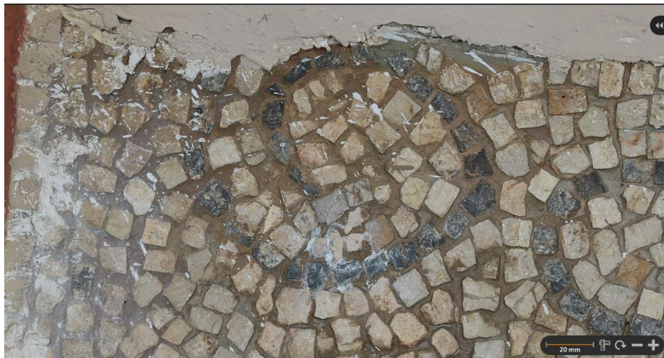
Fig.23 Zona con manchas de pintura y restos de morteros
