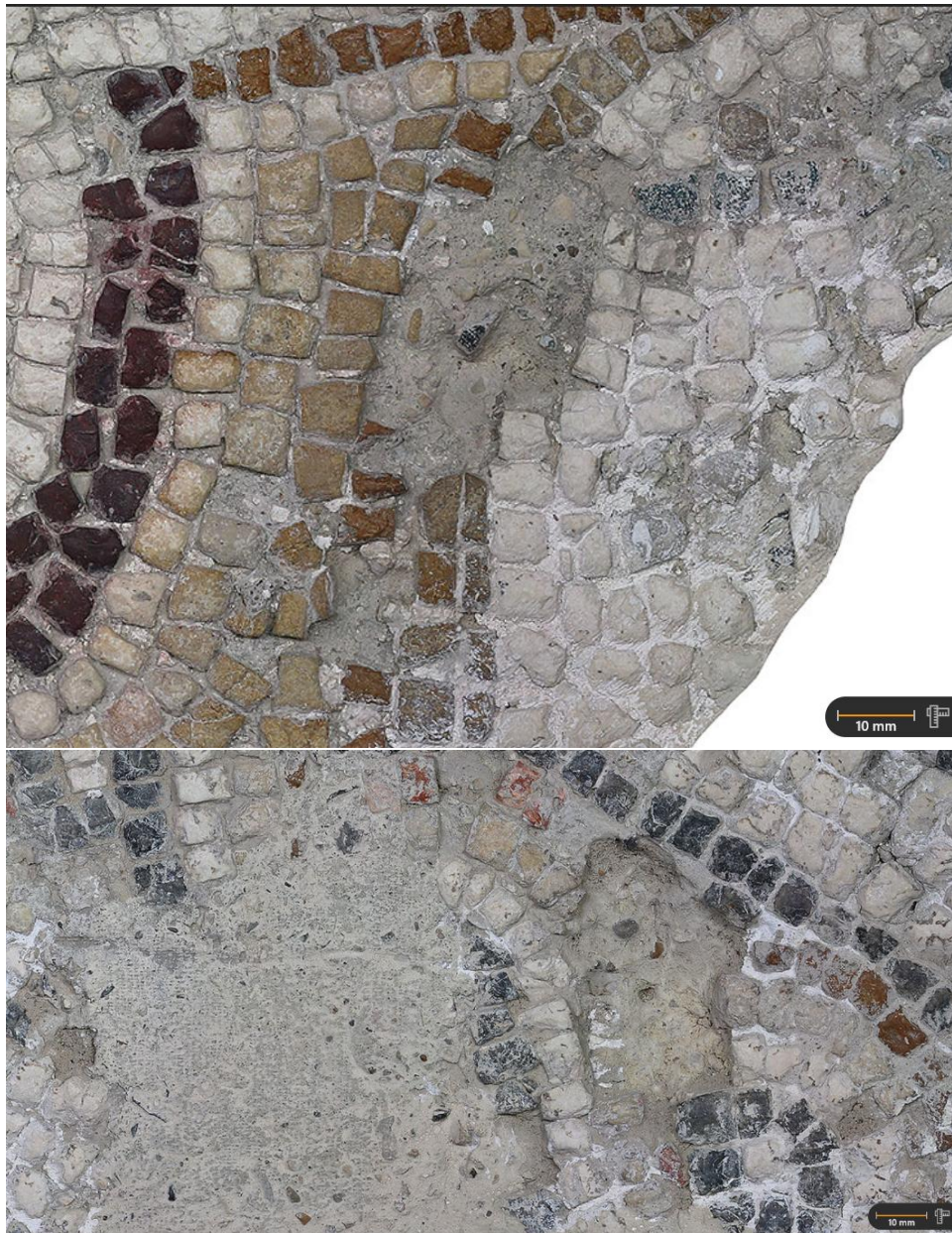
Fig. 16. Mortero del soporte disgregado ocasionando desprendimiento de teselas, Lagunas reintegradas con morteros de cemento
